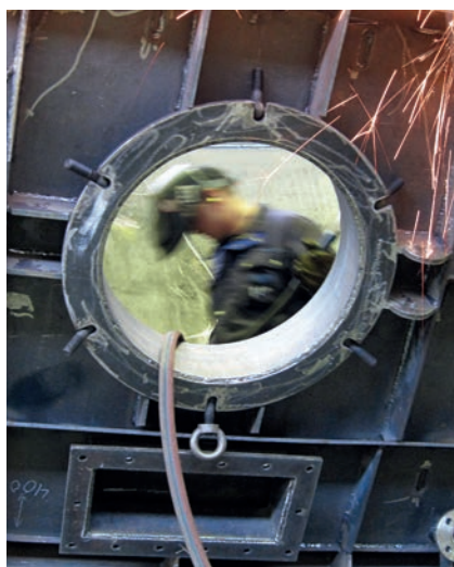
INVÄNDNING SVETS- NING AV DIFFUSOR
